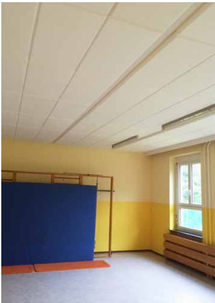
Die neue Akustikdecke im Turnsaal
